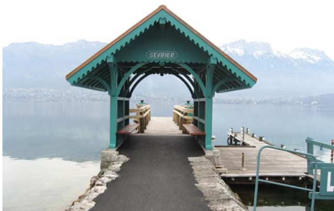
Débarcadère de Sevrier après travaux – Sébastien Crétet / SILA
