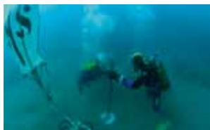
Mise en position d'une ancre à 1 étage de spire
