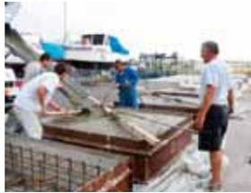
Coulage du béton avec maintien de l'anneau de manutention
