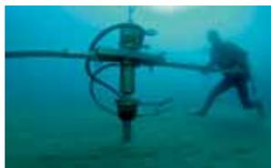
Vissage direct par clé hydraulique
