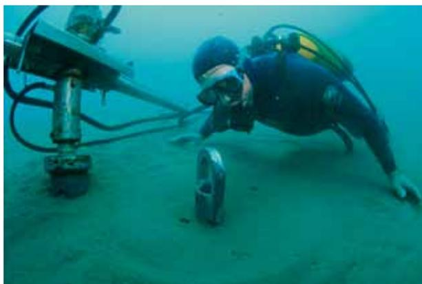
Vissage de l'ancre jusqu'à affleurement du sol
