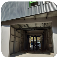
Couverture de l'aire de lavage
