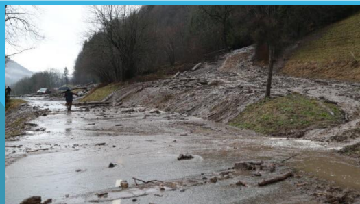
Coulée de boue sur la RD216 – 2018 – Source: Le Dauphiné Libéré
