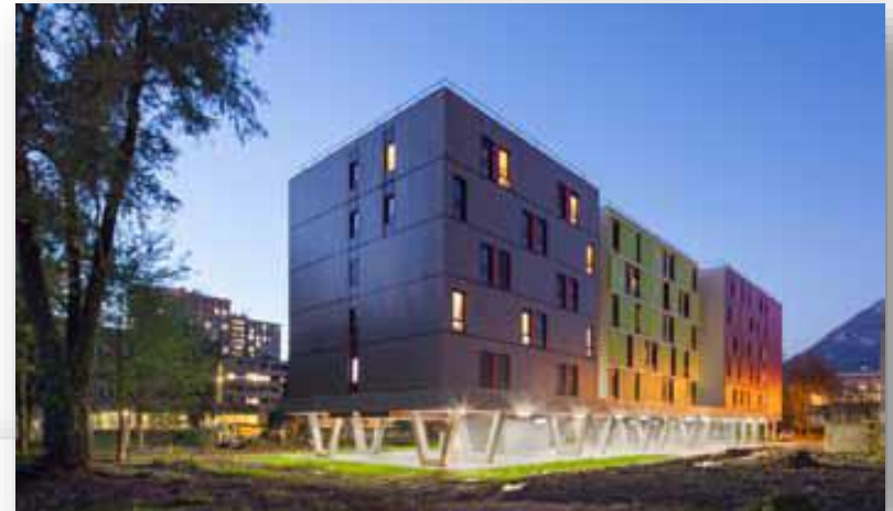
Bâtiment sur pilotis (Saint-Martin-d'Hères) Architecte : Ameller-Dubois
