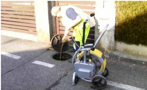
Un agent du service Entretien et Surveillance Réseaux en train de réaliser la reconnaissance de matériau au moyen d'une caméra poussée.
