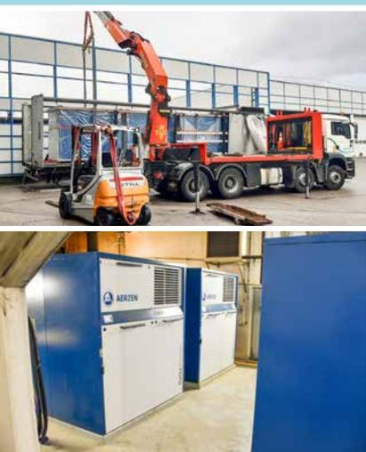
Les surpresseurs de lavage de SILOÉ ont été remplacés après 27 ans de service. Ces machines AERZEN de 4 tonnes produisent les 7 000 m³/h d'air surpressé nécessaire au nettoyage des 300 m³ de biolite présent dans chaque biofiltre.
