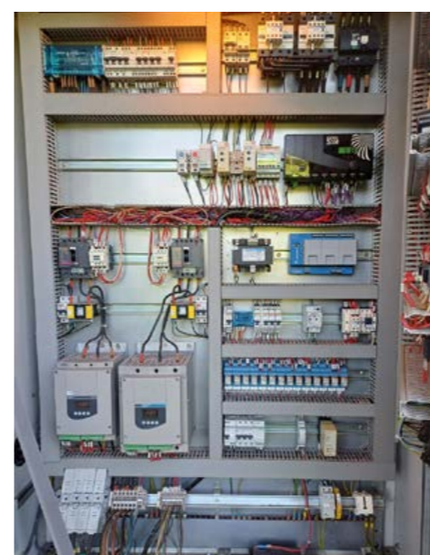
Câblage de nouveaux SOFREL S4W en cours sur une armoire STPO
